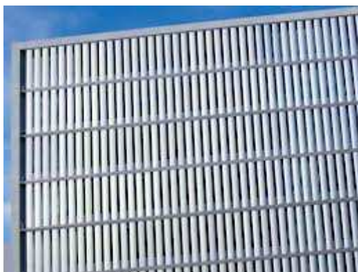
Figura 33. Esempio di schermatura per stenditoi
