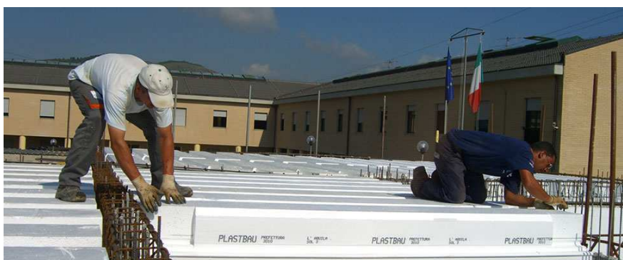
Figura 6. Esempio di posa in opera del solaio
