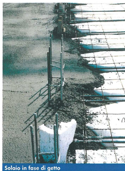
Figura 7. Getto di calcestruzzo sul solaio
