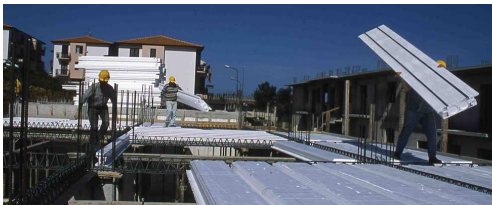
Figura 5. Esempio di posa in opera del solaio
