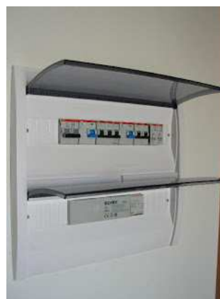
Figura 41. Esempi di quadri elettrici condominiale e da appartamento
